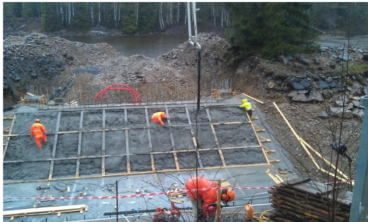
Magring av byggegrua
