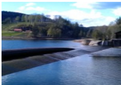
Kjeldal og Lunde Gummipølsedammer nedtappet, senket vannstand i kanalen med ca. 2,3m
