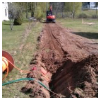
Strøm og fibertrekkerør ble gravd ned.
