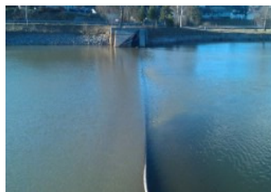
Kjeldal og Lunde Gummipølsedammer nedtappet, senket vannstand i kanalen med ca. 2,3m
