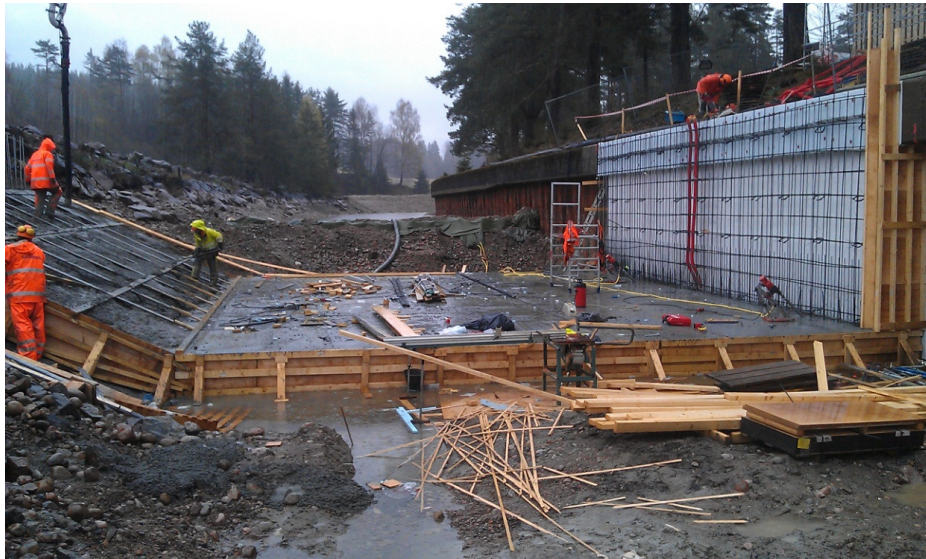
Systemforskalling ble brukt på denne veggen, høyde 4m.
