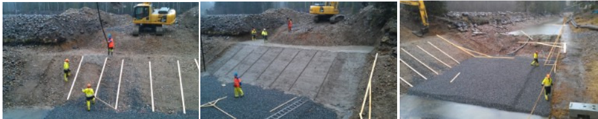
Etter utgraving av masser, var det klart for avretting og pukking.
