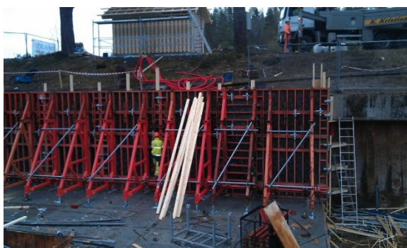
Systemforskalling ble brukt på denne veggen, høyde 4m.
