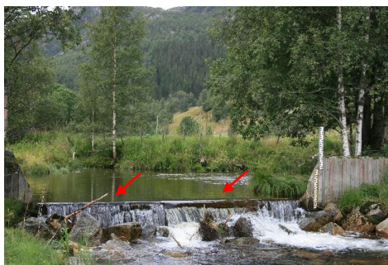
Bilder 5.1-5.3: Bjørnestadvatn var på undersøkelsestidspunktet lite nedtappet. Bilde viser rensing av garn og systematisering av fangst. Bilde fra hovedinnløpsbekken viser rester av gammel dam som mulig har oppgangshindrende effekt på lav vannføring (røde piler)
