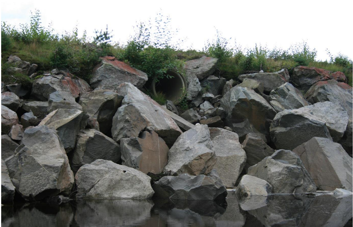
Bilde 4.6: Bekk ved Lukehuset i Nespervatnet går gjennom en storsteinet vegfylling. Stikkrennen ligger høyt i vegfyllingen, og er normalt ikke vannfylt. Passasje for fisk gjennom vegfylling kan være problematisk.
