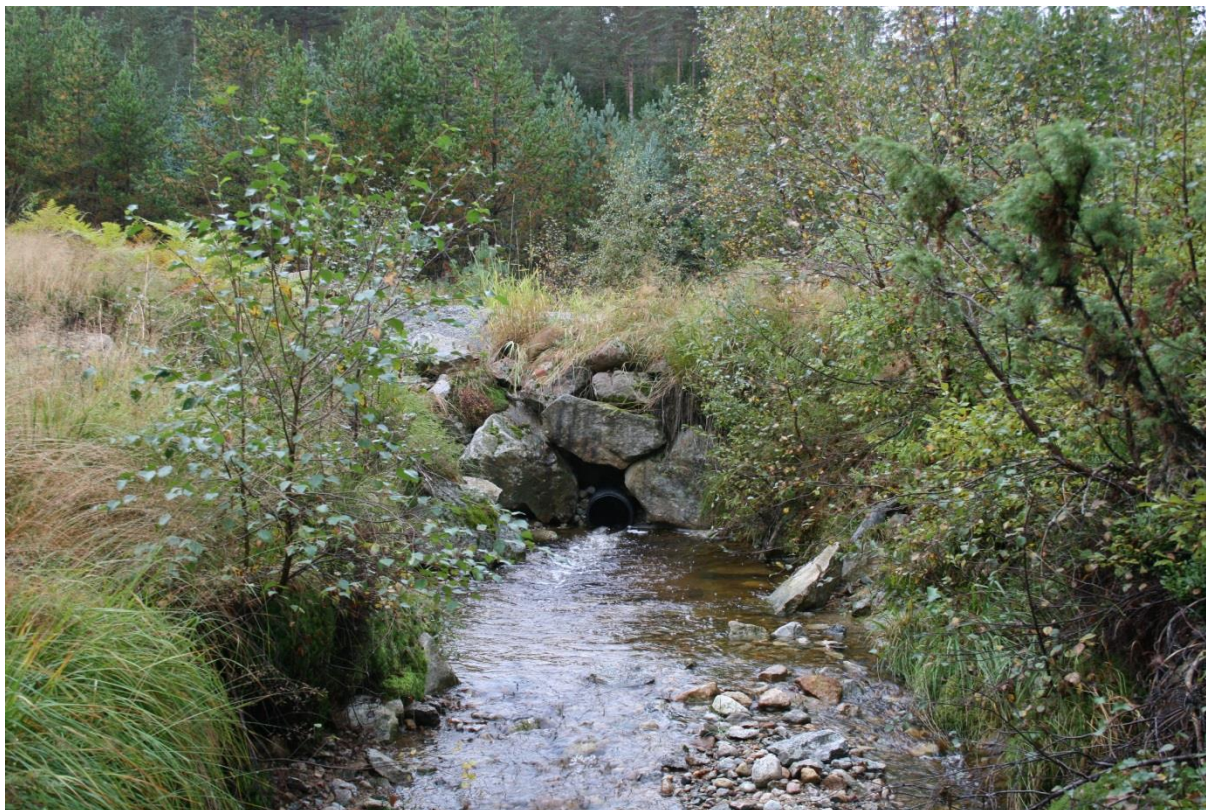
Bilde 8.2. Parti fra innløpsbekken til Nedre Løyntjønn som har partier med egnet substrat. Røret under veien ligger dypt og synes ikke å ha oppgangshindrende effekt. Tilgjengelig gyteareal oppstrøms vei er begrenset.
